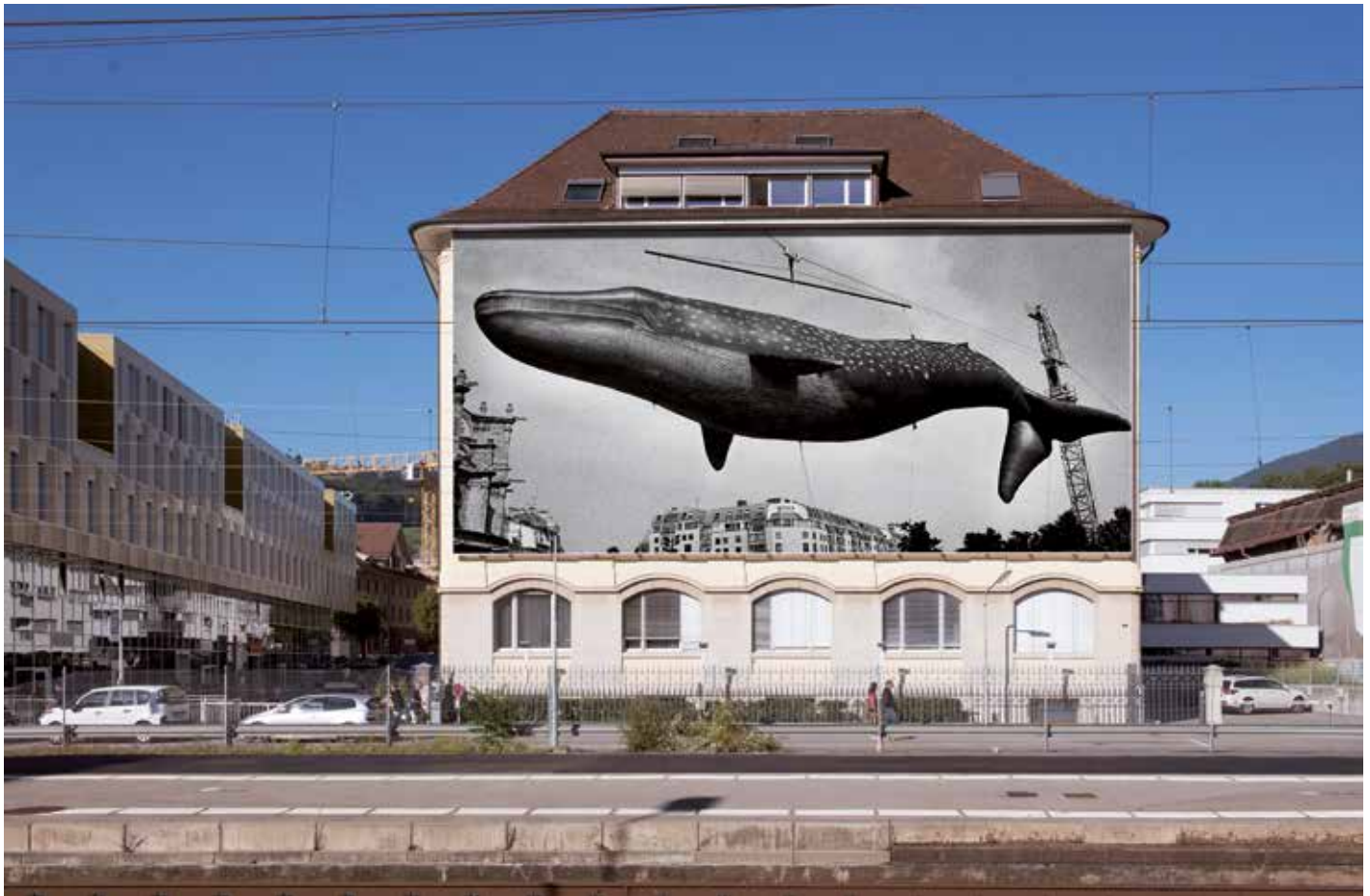
A tale of II Cities 4, Paris, 1989 von Daido Moriyama auf der Fassade von Andritz Hydro, ab September 2018 in Vevey zu entdecken (Fotomontage). Photo: Delphine Schacher © Daido Moriyama
